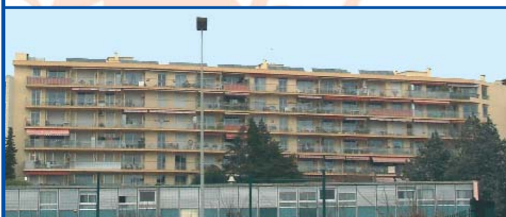
La copropriété Les Glycines - Crédit Transénergie
